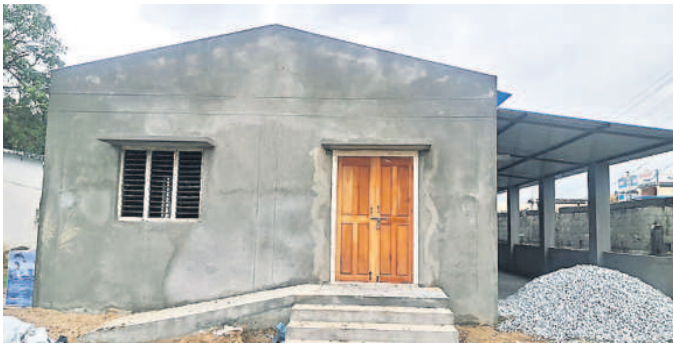
మునుగోడు జడ్చీ ఉన్నత పాఠశాలలో చివరి దశకు చేరుకున్న భోజనశాల నిర్మాణం
