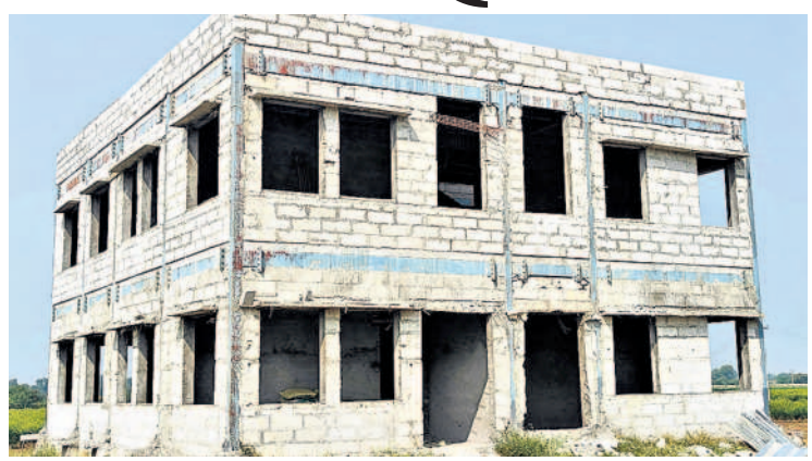
తాండూరులో నిర్మాణం అగ్రిహబ్ కార్యాలయం
