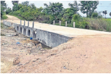
మల్లగూడెంలో నిర్మించిన కల్వర్టు
