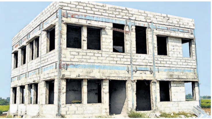
తాండూరులో నిర్మాణం అగ్రిహబ్ కార్యాలయం
