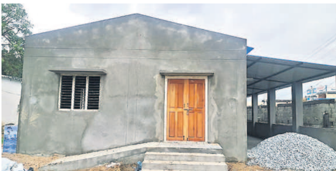
మునుగోడు జడ్పీ ఉన్నత పాఠశాలలో చివరి దశకు చేరుకున్న భోజనశాల నిర్మాణం
