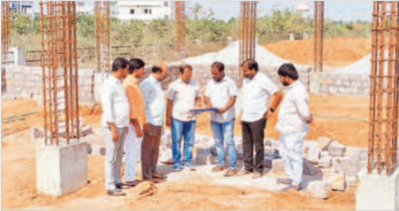
కడపల్లో ఎంపీడివో భవన నిర్మాణ పనులను పరిశీలిస్తున్న జెడ్పీటీసీ దశరథ్ నాయక్
