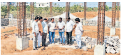
పనులను పరిశీలిస్తున్న జడ్పీటీసీ దశరథ్ నాయక్
