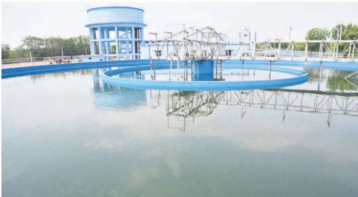
అర్బన్ మిషన్ భగీరథలో భాగంగా ఏర్పాటు చేసిన ఫిల్టర్ బెడ్
