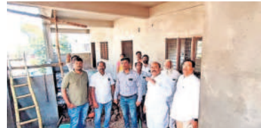
స్కూల్ భవన నిర్మాణ పనులను పరిశీలిస్తున్న కార్పొరేటర్ రవీందర్ రెడ్డి తాయని తెలిపారు. కార్యక్రమంలో స్థానికులు తదితరులు పాల్గొన్నారు.
