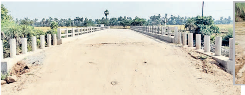
వెన్నారం శివారంలో గంగమ్మ గుడి వద్ద కల్వర్టుపై నిర్మించిన హైలెవల్ బ్రిడ్జి
