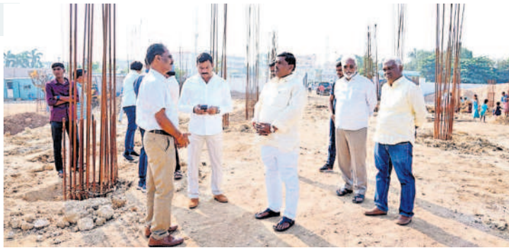
సూపర్ స్పెషాలిటీ దవాఖాన నిర్మాణ పనులను పరిశీలిస్తున్న ఎమ్మెల్యే గూడెం మహిపాల్ రెడ్డి
