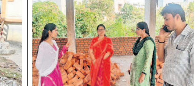
నామాలగుండులో వార్డు కార్యాలయ నిర్మాణ పనులను జీహెచ్ఎంసీ అధికారులతో కలిసి పరిశీలిస్తున్న కార్పొరేటర్ హేమ
