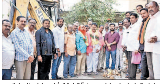
బాప్టిస్టు చర్చి వద్ద తాగునీటి పైపులైన్ నిర్మాణ పనులను ప్రారంభించిన ముషీరాబాద్ ఎమ్మెల్యే ముతా గోపాల్
