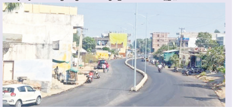
మహాత్మాగాంధీ విగ్రహం నుంచి పూర్తయిన జిటీ రోడ్డు నిర్మాణం
