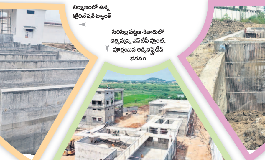
నిర్మాణంలో ఉన్న జిల్లినేషన్ ట్యాంక్
