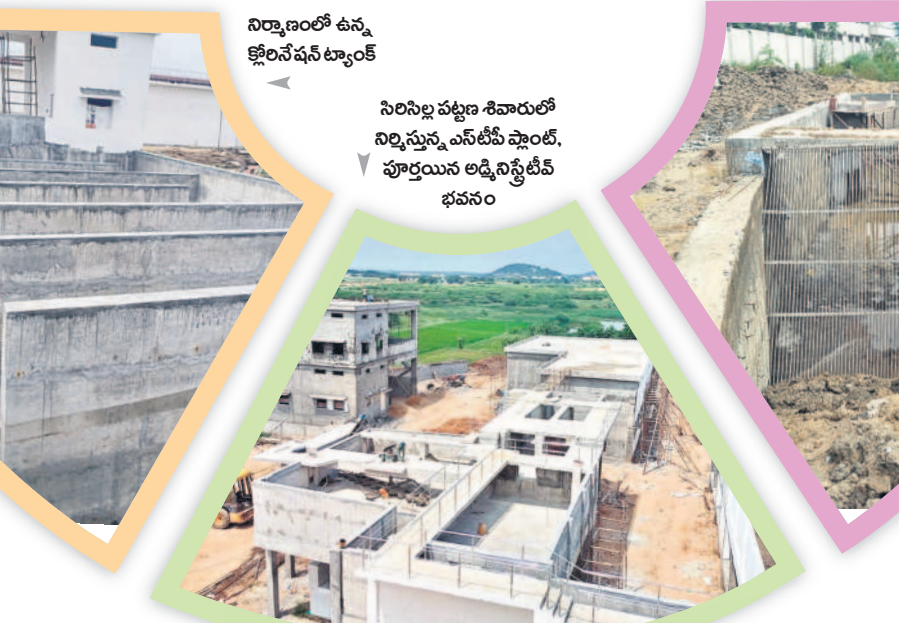
నిర్మాణంలో ఉన్న జ్యోతి నేషనల్ ట్యాంక్
