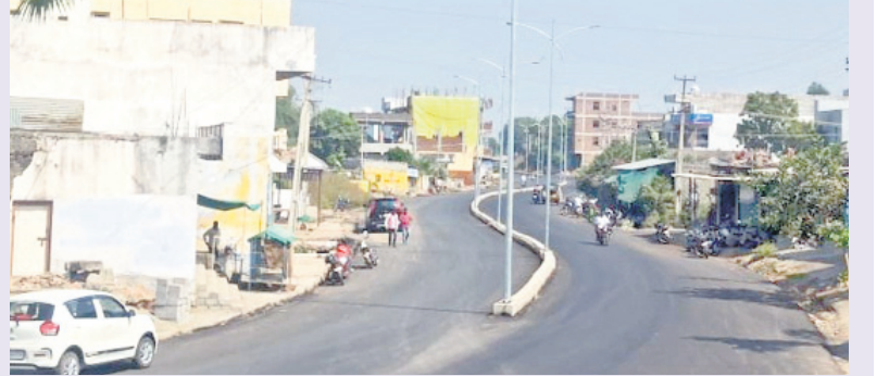
మహాత్మాగాంధీ విగ్రహం నుంచి పూర్తయిన జిటీ రోడ్డు నిర్మాణం
