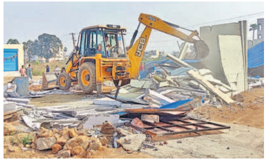
అక్రమ నిర్మాణాలను కూల్చివేస్తున్న రెవెన్యూ అధికారులు
