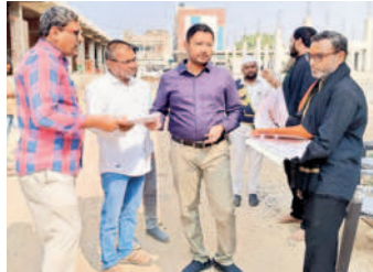
నిర్మాణ పనులను పరిశీలిస్తున్న కమిషనర్
