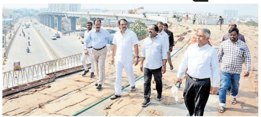
బైరామల్ గూడ జంక్షన్లో నిర్మాణంలో ఉన్న లూప్లను పరిశీలిస్తున్న ఎల్సీ నగర్ ఎమ్మెల్యే దేవిరెడ్డి సుధీర్ రెడ్డి, అధికారులు
