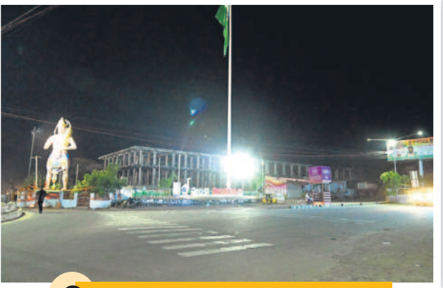
రాత్రి 11.15 గంటలు... నిర్మాణస్థలంగా ఉన్న ఐటీ చౌరస్తా
