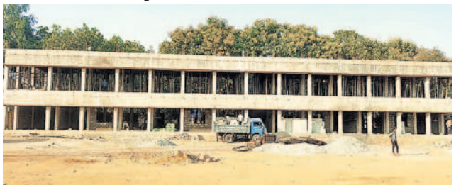
కొనసాగుతున్న జూనియర్ కళాశాల భవన నిర్మాణ పనులు
