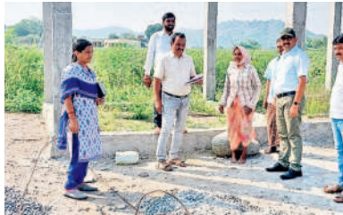
కొత్తగట్టులో గృహ నిర్మాణాన్ని పరిశీలిస్తున్న రాంరెడ్డి
