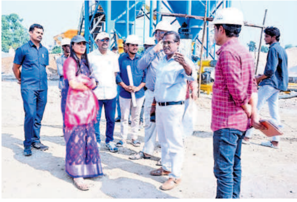
నిర్మాణ పనులను పరిశీలిస్తున్న కలెక్టర్ ప్రావీణ్య
