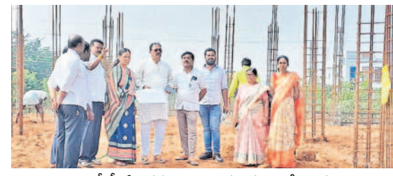
ఎంపీపీవో భవన నిర్మాణ పనులను పరిశీలిస్తున్న ఎంపీపీ కమ్మిమోత్యానాయక్
