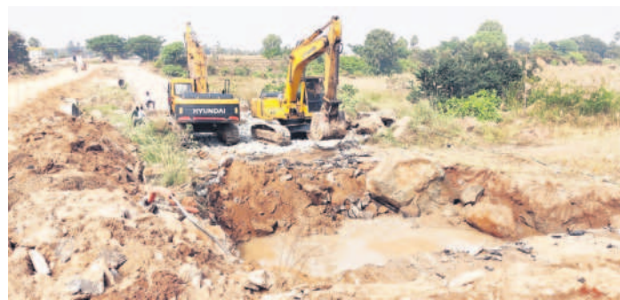
గంభీరావుపేట మానేరు వాగుపై ప్రారంభమైన హైలెవల్ వంతెన నిర్మాణ పనులు
