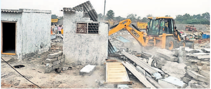
గాజులరామారంలో అక్రమ నిర్మాణాల కూల్చివేతలు
