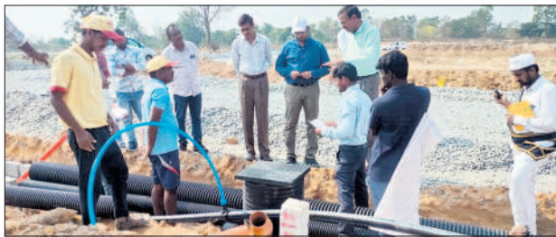
లే అవుట్ ప్రాంతంలో అభివృద్ధి పనులను పరిశీలిస్తున్న షేక్ రిజిస్ట్రార్ బాషా
