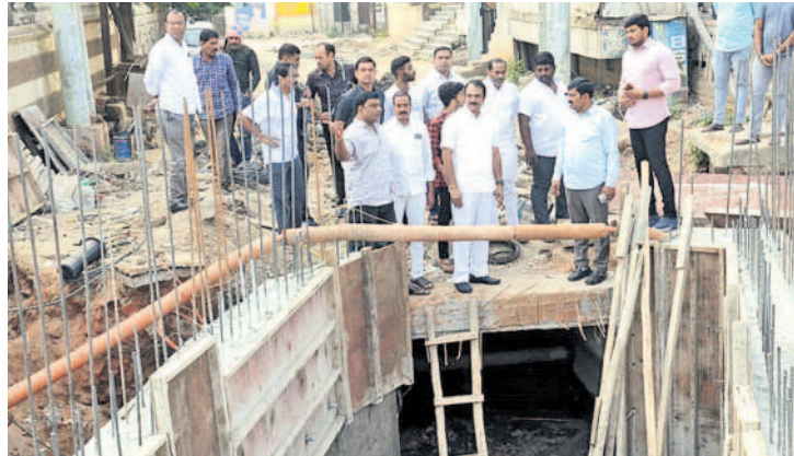
మల్ రెడ్డి రంగారెడ్డి నగర్ లో బాక్స్ డ్రెయిన్ నిర్మాణ పనులు పరిశీలిస్తున్న ఎమ్మెల్యే దేవిరెడ్డి సుధీరరెడ్డి
