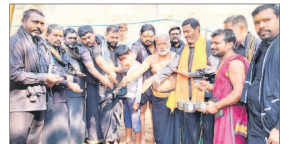
కోరుట్ల: నీటి తొట్టి నిర్మాణ పనులకు భూమి పూజ చేస్తున్న కమిటీ సభ్యులు
