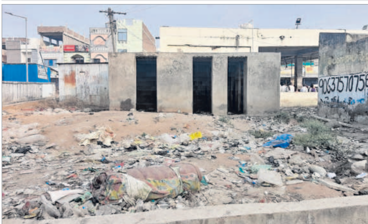
నిర్మాణ దశలో ఉన్న మరుగుదొడ్డు
