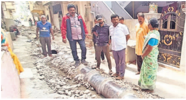
వినాయకనగర్లో సీవర్జేట్ లైన్ పనులను పరిశీలిస్తున్న కార్పొరేటర్ వెంకటేశ్
