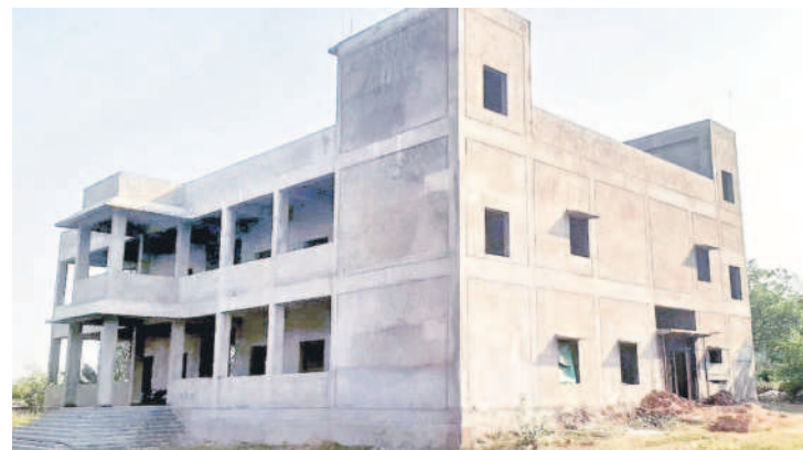
కొనసాగుతున్న కల్యాణ మండపం నిర్మాణం
