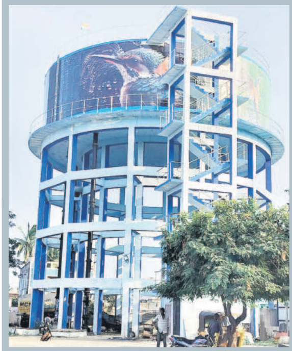
గాంధీ పార్కులో మిషన్ భగీరథ తాగునీరు అందించే ఓవర్ హెడ్ ట్యాంకు
