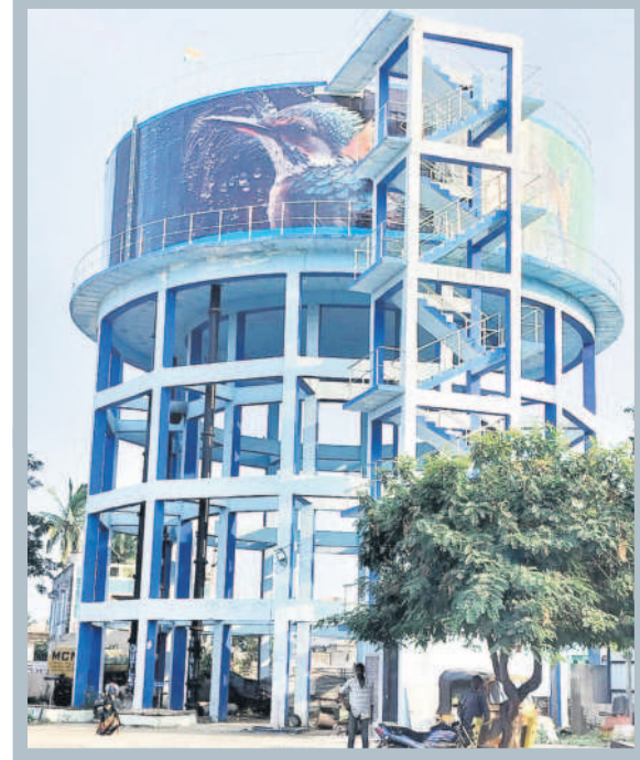
గాంధీ పార్కులో మిషన్ భగీరథ తాగునీరు అందించే ఓవర్ హెడ్ ట్యాంకు
