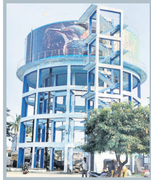
గాంధీ మార్కెట్ మిషన్ భగీరథ తాగునీరు అందించే ఓవర్ హెడ్ ట్యాంకు
