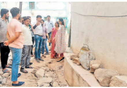
చిలకలగూడలో జరుగుతున్న సీసీ రోడ్డు నిర్మాణ పనులను పరిశీలిస్తున్న కార్పొరేటర్ హేమ తదితరులు
