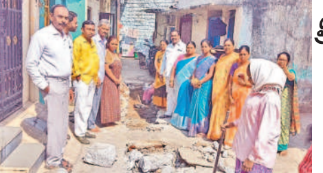
భోలకొండలో డ్రైనేజీ పైపులైన్ పనులను ప్రారంభిస్తున్న కార్పొరేటర్ హేమలత
