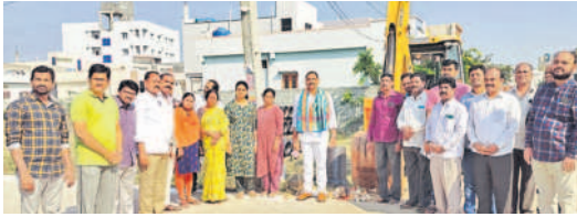
అండర్ గ్రౌండ్ డ్రైనేజీ పనులకు శంకుస్థాపన చేసిన కౌన్సిలర్
