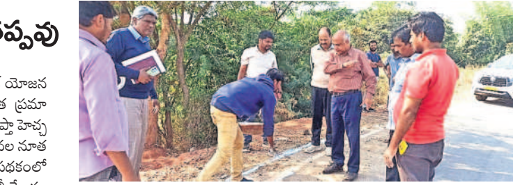
బీటీ రోడ్డు నిర్మాణ పనులను పరిశీలిస్తున్న నేషనల్ క్వాలిటీ మానిటర్ శివకుమార్ గుప్తా తదితరులు
