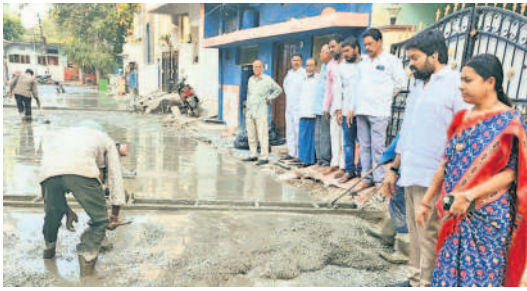
సీసీ రోడ్డు పనులను పరిశీలిస్తున్న కార్పొరేటర్ శాంతి
