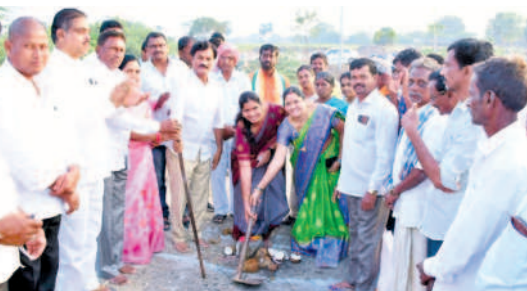
కమ్యూనిటీ హాల్ ప్రహారీ నిర్మాణ పనులకు శంకుస్థాపన చేస్తున్న ఎమ్మెల్యే కుంభం అనిల్ కుమార్ రెడ్డి
