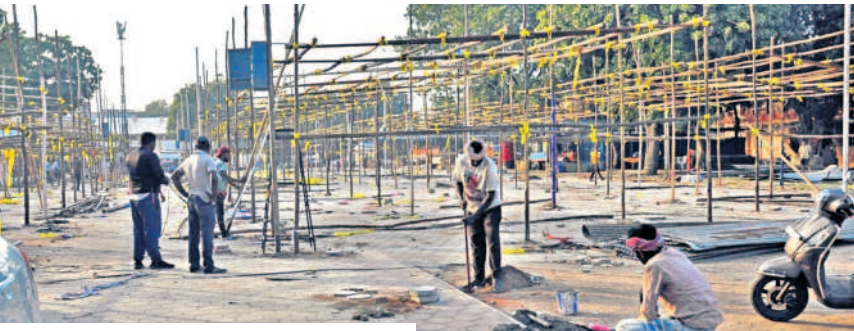
స్టాల్ నిర్మాణ పనులను చేపడుతున్న కార్మికులు
