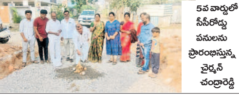
5వ వార్డులో సీసీ రోడ్డు పనులను ప్రారంభిస్తున్న చైర్మన్ చంద్రారెడ్డి
