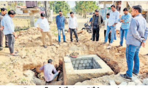
అయోధ్యనగర్ కాలనీలో భూగర్భ డ్రైనేజీ నిర్మాణ పనులు పరిశీలిస్తున్న మేయర్ వెంకటరెడ్డి
