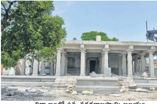
నిర్మాణంలో ఉన్న వరదరాజస్వామి ఆలయం
