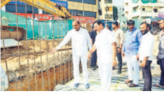
లింగంపల్లి రైల్వే అండ్ర్ బ్రడ్డి వద్ద కొనసాగుతున్న పనులను పరిశీలిస్తున్న ఎమ్మెల్యే అరెకపూడి గాంధీ
