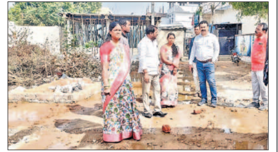
ఘట్టేసర్ 7వ వార్డులో సీసీ రోడ్డు నిర్మాణ పనులను పరిశీలిస్తున్న మున్సిపల్ చైర్పర్సన్ పావనీజంగయ్య యాదవ్
