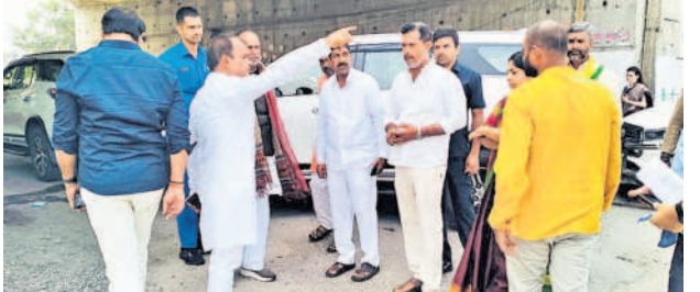
అవుషాపూర్లో అండర్ పాస్ నిర్మాణ స్థలాన్ని పరిశీలించిన ఎంపీ డాక్టర్ లక్ష్మణ్, ఎంపీపీ సుదర్శన్ రెడ్డి తదితరులు
