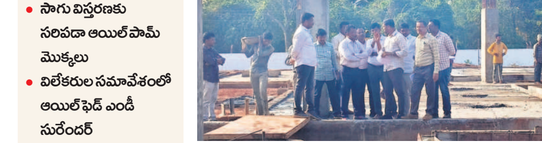
ఫ్యాక్టరీ నిర్మాణ పనులను పరిశీలిస్తున్న ఆయిల్ ఫెడ్ ఎండ్ సురేందర్
