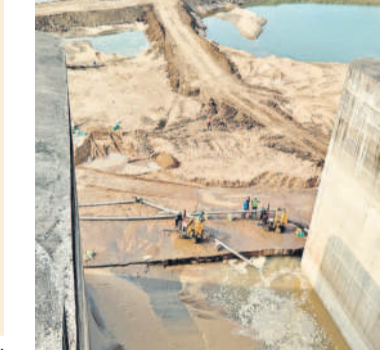
మేడిగడ్డ బరాజ్ వద్ద కొనసాగుతున్న ఇన్వెస్టిగేషన్ పనులు
